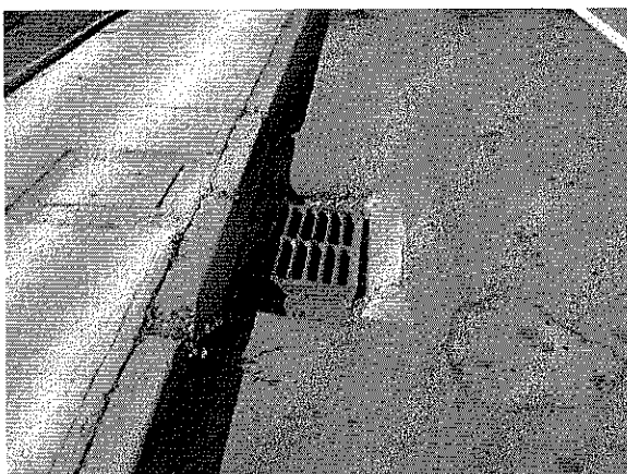
Foto 28. Falta de terminación en encuentro entre sumidero y pavimento.
